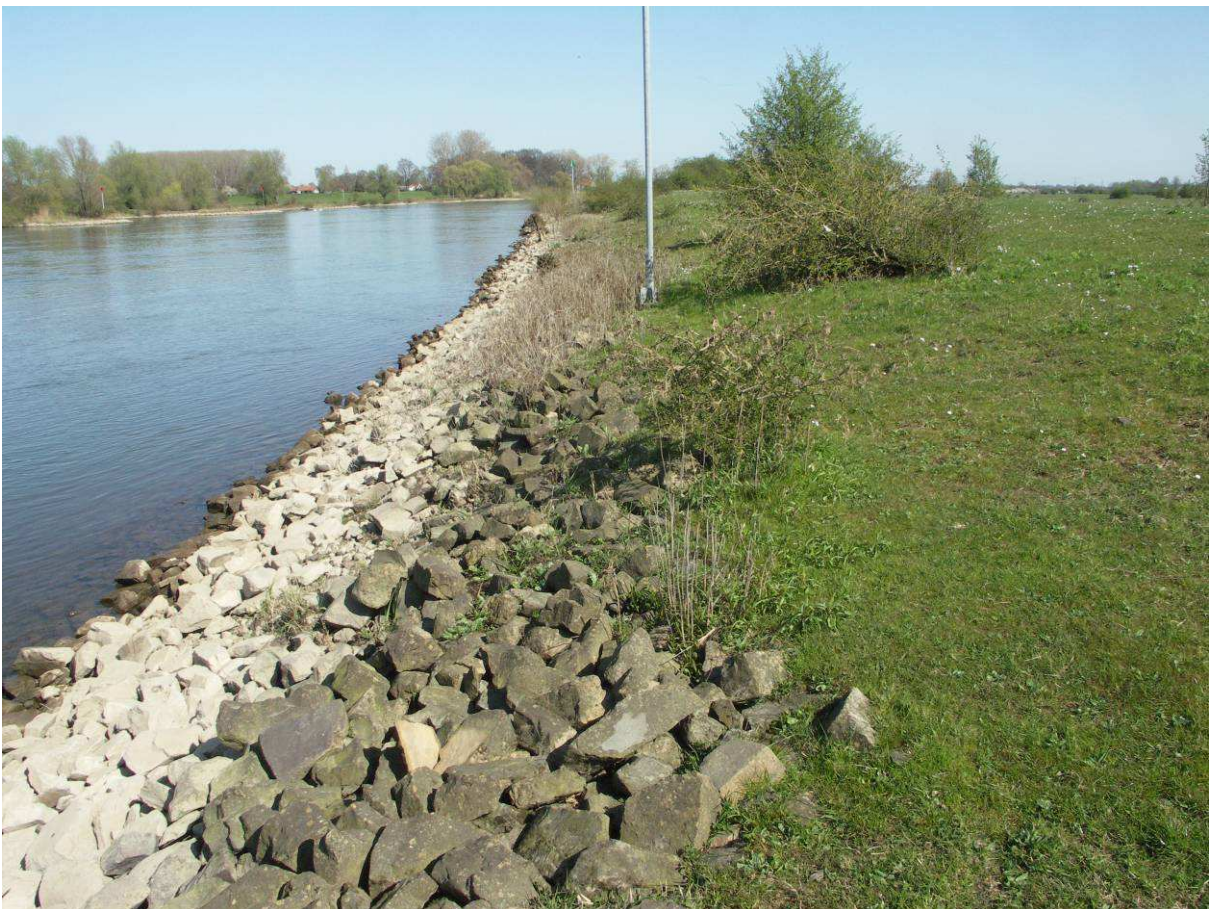
De vastgelegde oevers van de gekanaliseerde IJssel bij Cortenoever nabij Zutphen.
